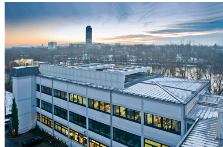
Dienststelle Nürnberg, Voigtländerstraße (Rechenzentrum Nord)
