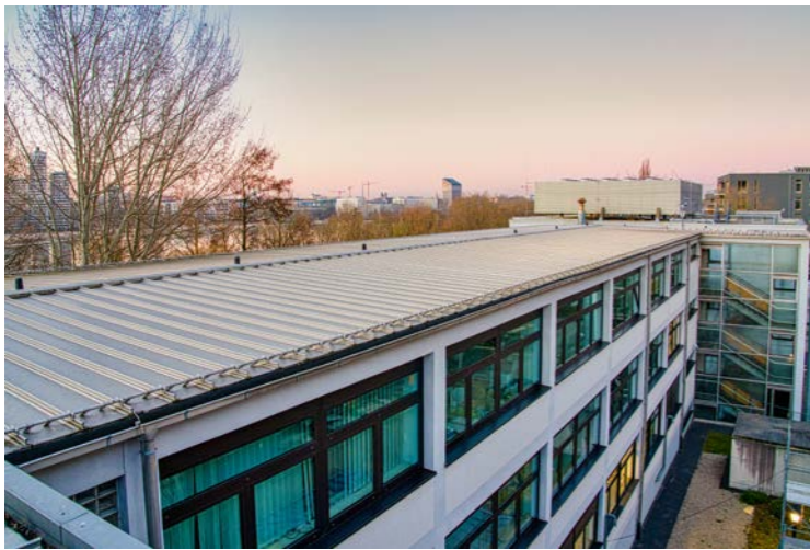
Das RZ-Nord am Wöhrder See in Nürnberg
